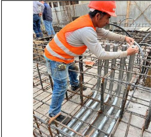
**Tubería para Transformadores.**
